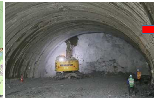
ブレイカーで岩盤を掘削しています。
