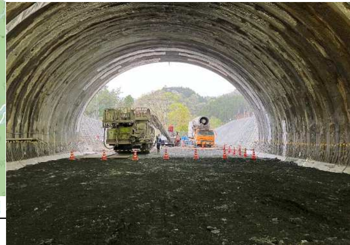
トンネル掘削も完了し、トンネル内から大滝落合地区が見えるようになりました。今は、インバートコンクリートを打設しています。
