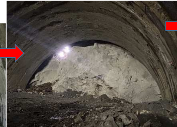
貫通の瞬間、外の光がトンネルに差し込みました。この瞬間が一番感動します。
