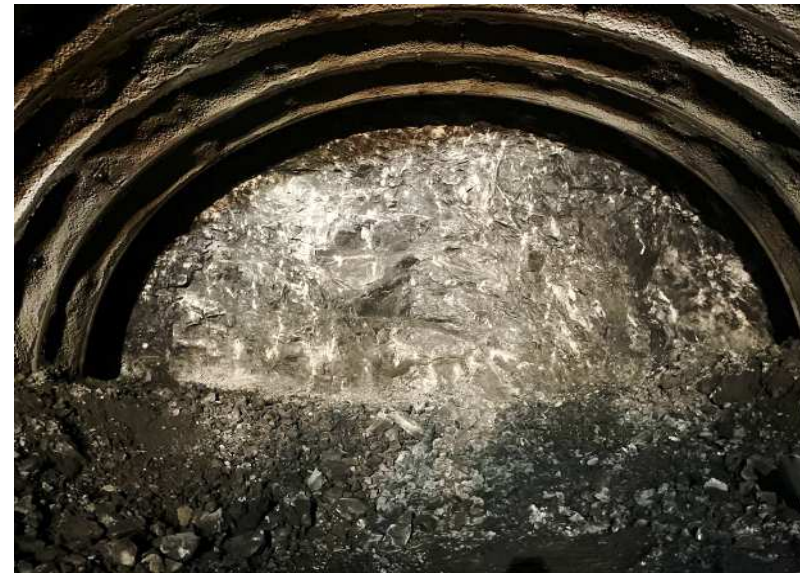
トンネル掘削箇所の地山です。
