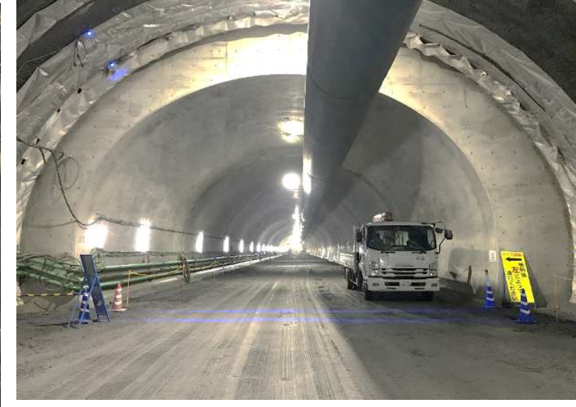
覆工コンクリートも約300m進みました。
